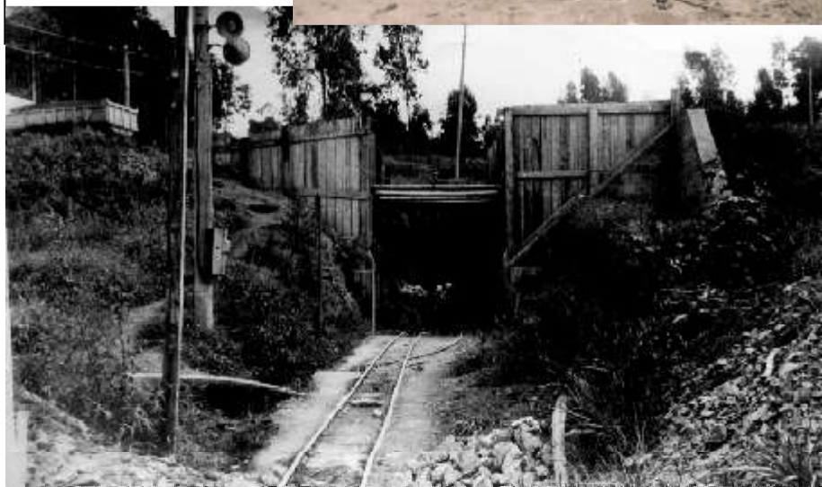
Sistema de alimentação de calcário dos fornos na Cimento Portland Itaú em Arcos
